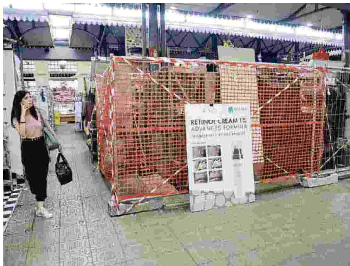
Uno dei cantieri aperti per sistemare la collocazione dei banchi del pesce
